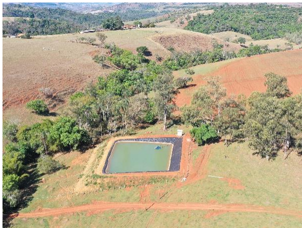
Figura 07: Vista aérea do piscinão.
